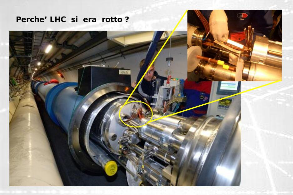
I magneti superconduttori di LHC sono interconnessi elettricamente da giunzioni in rame, saldate tra di loro (ce ne sono 30,000)
